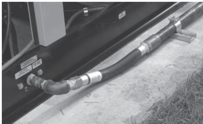
Figura 1.8 — Linha de combustível flexível
