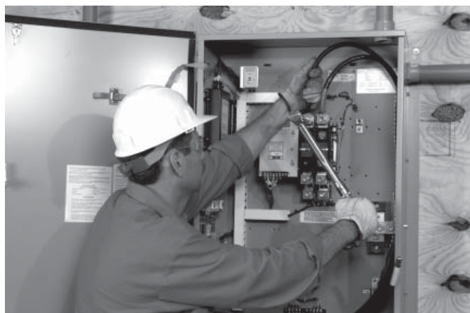
Рисунок 3.5. Затягивание клемм
