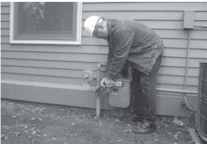
Figura 1.7 - Válvula de cierre manual
