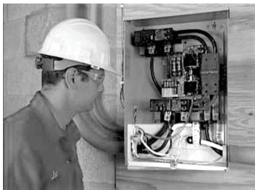
Figura 2.1 - Conexión de los conductores de alimentación
