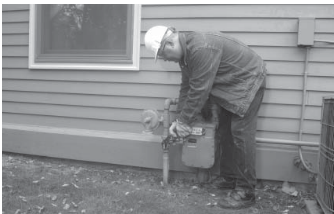
Figura 1.7 - Válvula de corte manual
