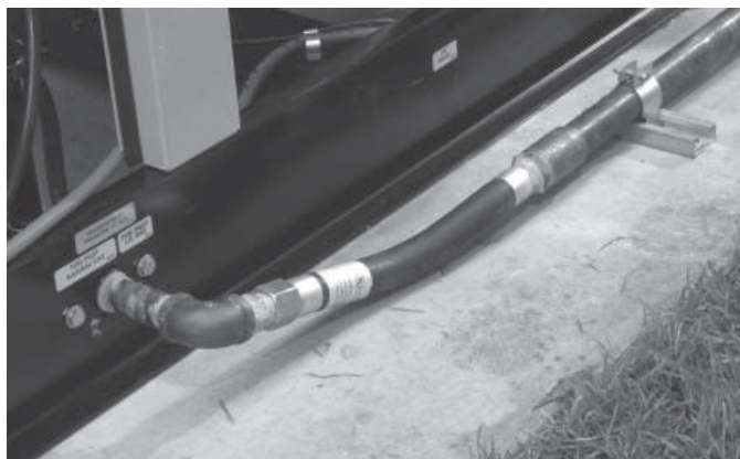
Рисунок 1.8. Гибкая топливная линия
