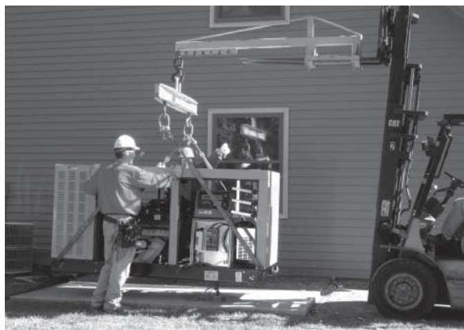
Рисунок 1.4. Подъем генератора
