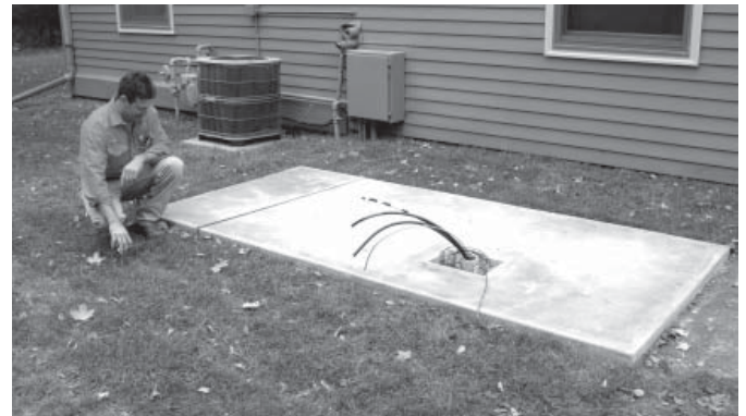
Figure 1.2 — Position Conduit
