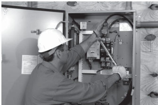
Figura 3.5 - Torque dos terminais
