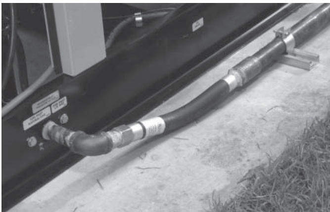
Figura 1.8 - Tubería de combustible flexible
