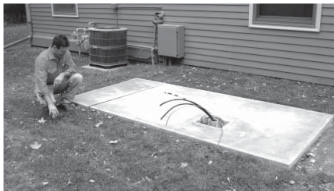
Рисунок 1.2. Расположение кабелепровода
