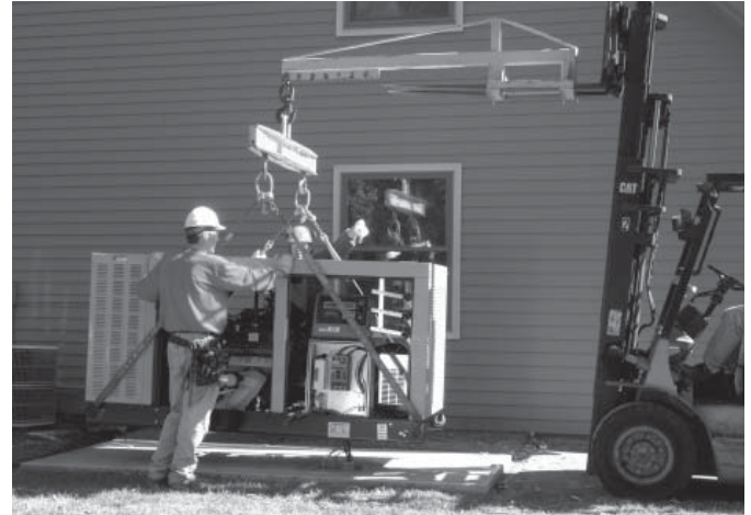
Figura 1.4 - Izado del generador
