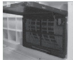
Ilustración B – Extracción del filtro de ventilación
