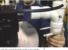
REMOVE SUPPORT BRACKET **FLUE BAFFLE**
