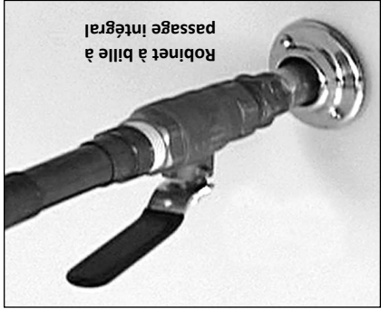
Figure 20 - Ouvrir complètement le robinet d'alimentation d'eau froide.
