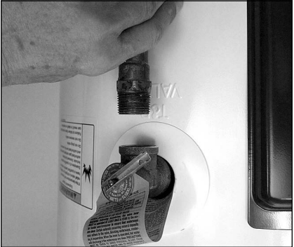
Figure 12 - Enlever le tuyau d'évacuation de la soupape de décharge DST.
