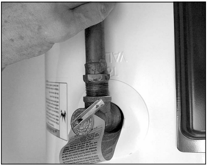
Figure 15 - Le tuyau d'évacuation de la soupape de décharge DST doit être installé correctement et canalisé à un drain adéquat.
