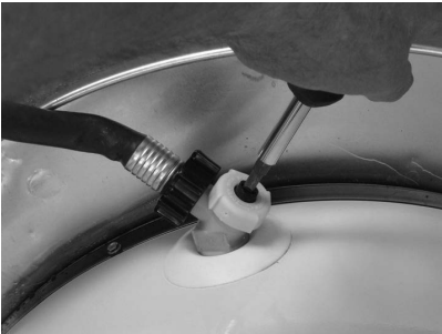
Figure 11 - Vidanger l'ancien chauffe-eau.
