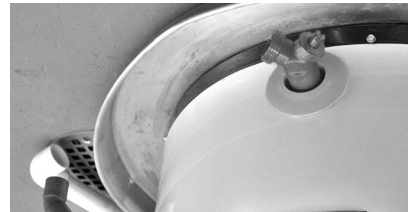
Figure 8 - Un bac de vidange approprié canalisé à un drain adéquat peut aider à protéger le plancher des fuites et des égouttements.
